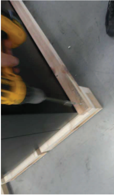
SVITARE IL LISTELLO DI LEGNO FRONTALE E POSTERIORE.
